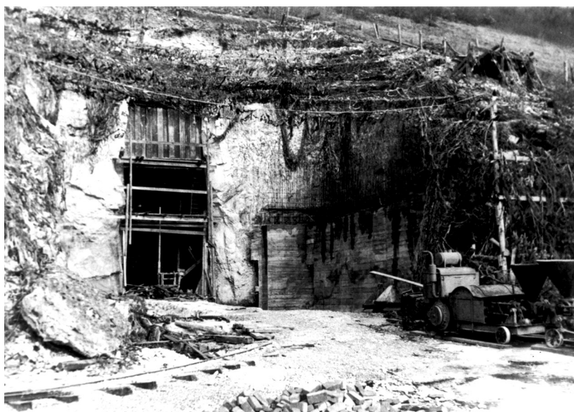
Entrée de la carrière C en plein chantier à la Libération. Les murs en béton armé devaient couvrir toute l'entrée comme devant la carrière A. On distingue au sol les rails de la grue devant soulever les trémies pleines de béton afin de les verser dans les coffrages des murs. La petite bétonneuse mécanique se trouve sur la droite avec deux trémies brassant le mélange et deux autres au sol. Les filets de camouflage sont toujours en place (Du Fw190 au NC900 / Photo H. Sufize).
